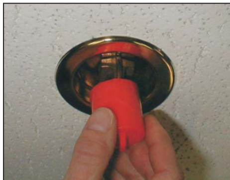
Abb.2: Die Schutzkappe wird von einem hängenden Sprinkler entfernt.
