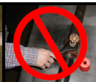
FALSCH! (Sprinkler am Boden)
